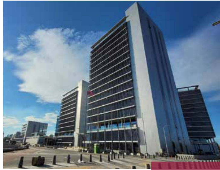
01 EDIFICIO OFICINAS DE GOBIERNO
